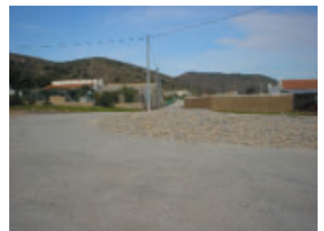
Parte final del camino asfaltado (G.L.G.)
