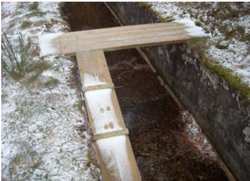
Rampa instalada y funcionando. Felix Herrero.
