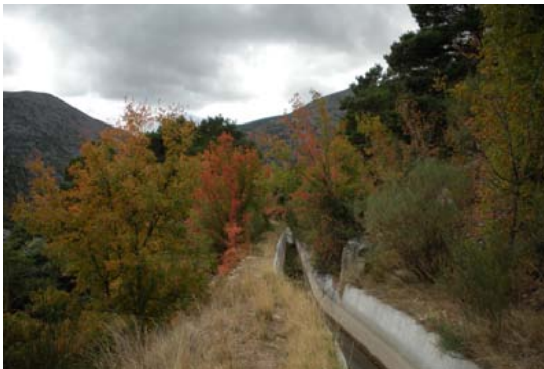
Estructura de reparto de caudales en el azud de Morca. Enrique Arrechea
