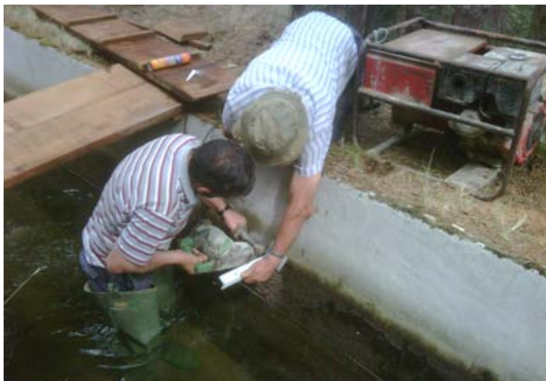
Instalación de las rampas en el canal. Agustín Clemente.
